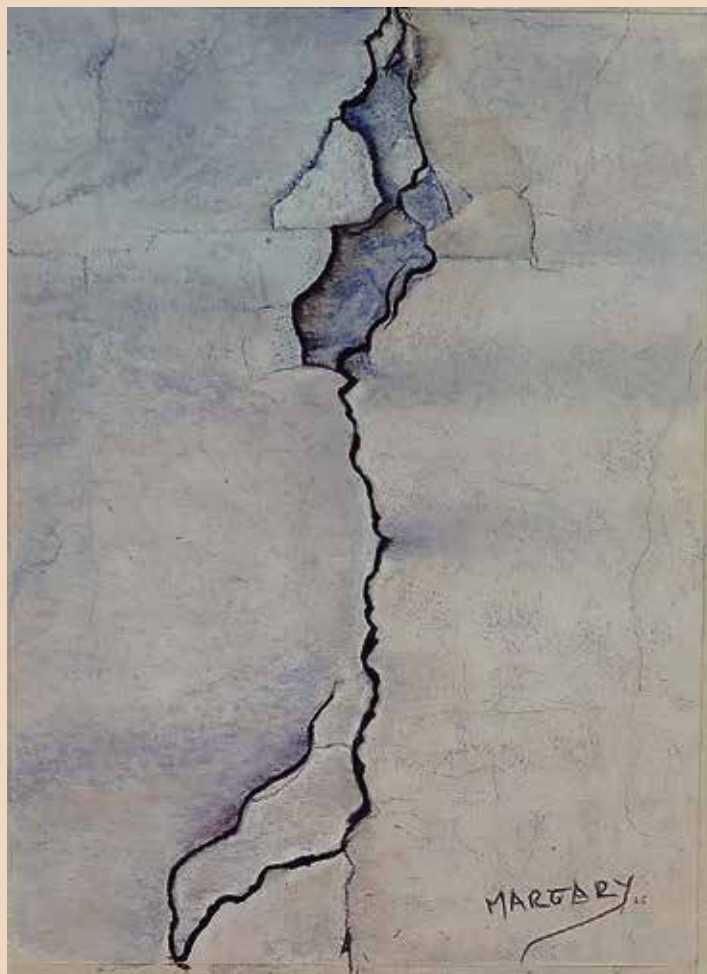
GRIETA - 30x40 cm.
